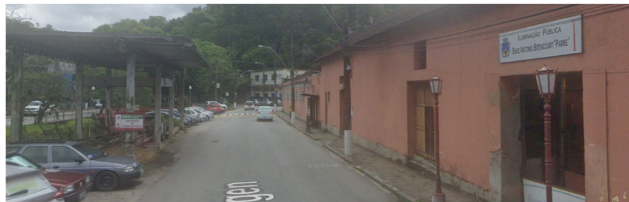
Figura 2.8: Possível local para implantação do novo Terminal - Antiga Instalação da Sec. Obras
