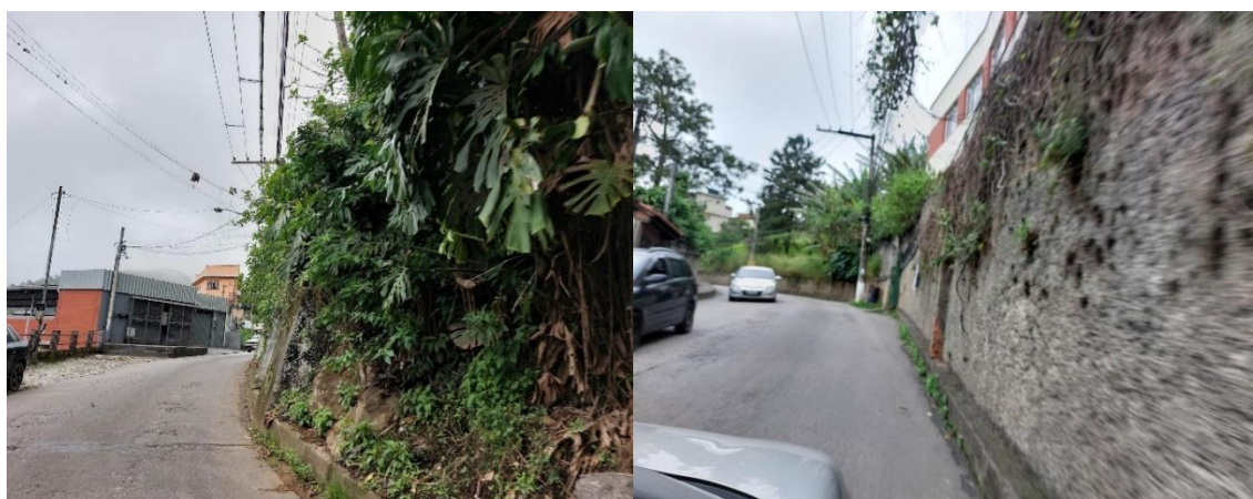
Figura 16: Exemplos de observação na Estrada da Saudade.
